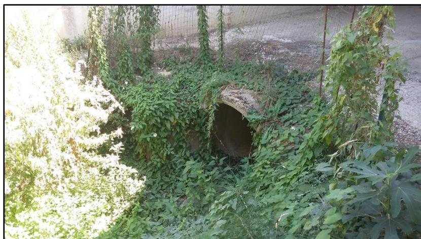
*Foto sezione A – dettaglio passaggio dall'alveo naturale al tubo in cls  $\phi = 1500\text{mm}$*
