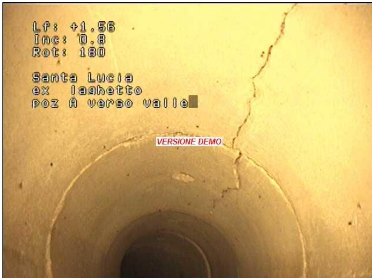
*Fig. 5.41 – Foto da videoispezione: lesioni strutturali*
