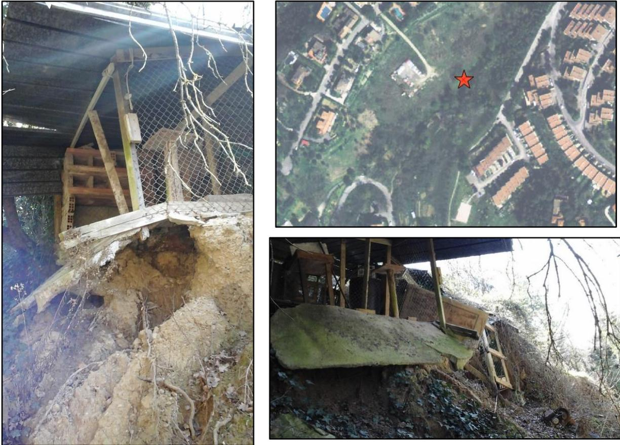
**Fig. 9.3** – Eventi di frane spondali in alveo, che causano, in alcuni punti, piccoli sbarramenti opponendosi al naturale deflusso delle acque; inoltre causano cedimenti del terreno di fondazione di piccole strutture abbandonate ubicate a ridosso del fosso (capanni per animali e rimesse per gli attrezzi).
