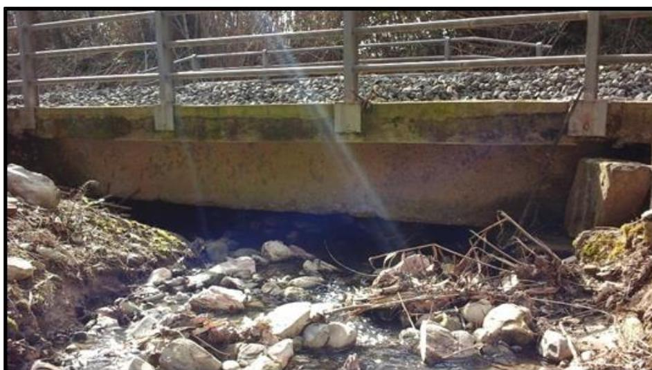
Fenomeni di deposito e di interrimento hanno nel tempo occluso quasi totalmente la sezione utile al deflusso al di sotto dell'attraversamento ferroviario, rendendola incompatibile con il transito delle portate attese (Capitolo 5 – Sezione H).
