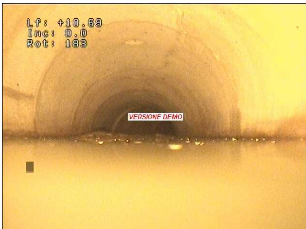
**Fig. 5.40** – Foto da videoispezione: interrimento della tubatura
