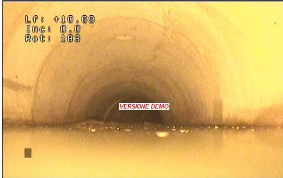
Il materiale solido trasportato da monte dalla corrente ha occluso considerevolmente la sezione, riducendo in modo significativo l'area utile al deflusso. Interventi di rimozione del materiale e di ripristino della sezione efficace originaria sono da prevedere quanto prima.
