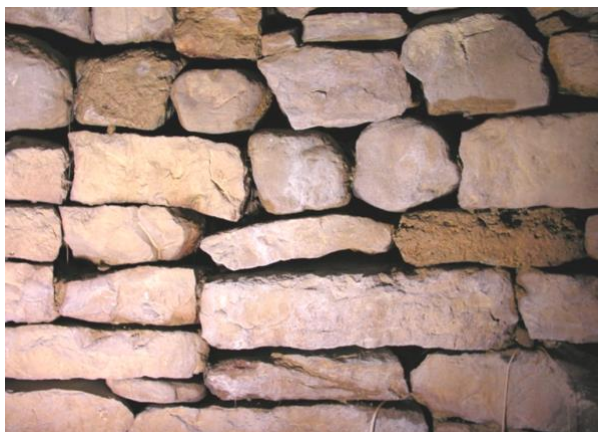
Figura 1.4 - Particolare della muratura in pietra
