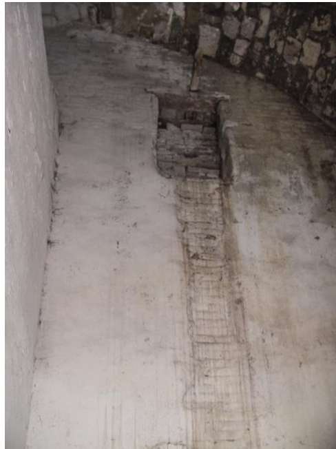
Figura 5.12 – Finestra di attingimento dal primo piano
