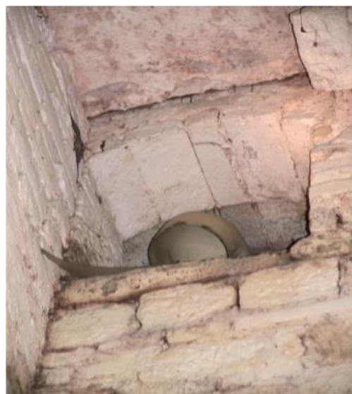
Figura 5.10 – Finestra di attingimento dai locali di Via Mattioli
