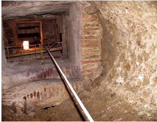
Figura 3.11 - Vista delle volte e mensole di sostegno alla muratura
