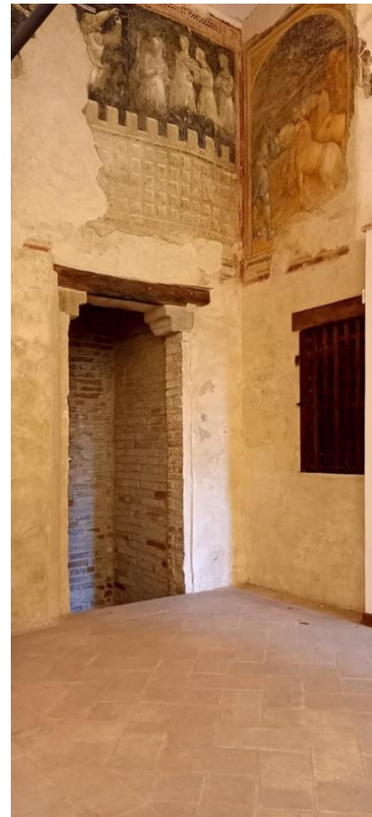
Figura 3.3 - Sala gotica prima e dopo il restauro
