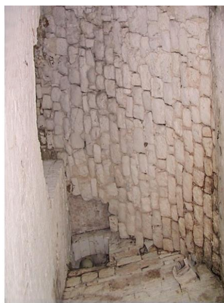
Figura 5.6 – La volta prosegue nel vano adiacente
