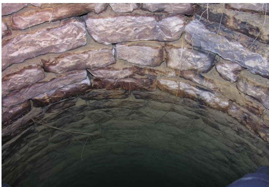
Figura 1.8 – Muratura della parte bassa del pozzo
