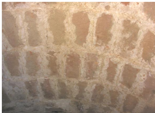
Figura 1.5 - Particolare della muratura in mattoni
