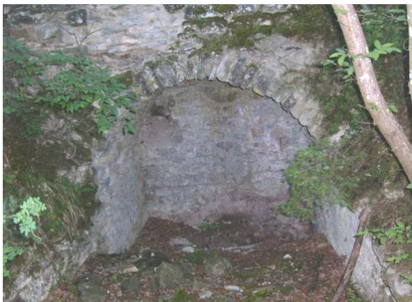
Figura 1.10 – Cisterna di Monte Cavallo, volta in pietra
