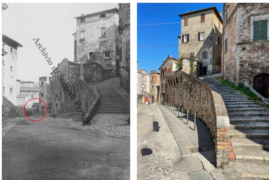
Figura 2.5 - Vista panoramica della parte terminale di via San Francesco foto di repertorio (© Archivio di Stato di Perugia) e odierna
