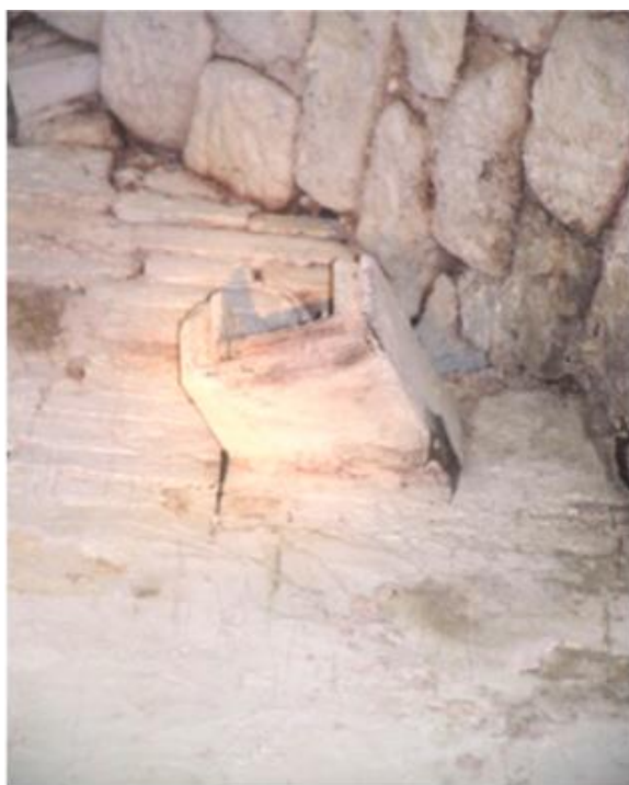
Figura 5.11 – Canale di alimentazione della cisterna
