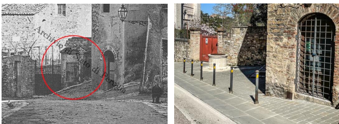
Figura 2.6 – Dettaglio dell'area dove insiste il pozzo (foto di repertorio e odierna)
