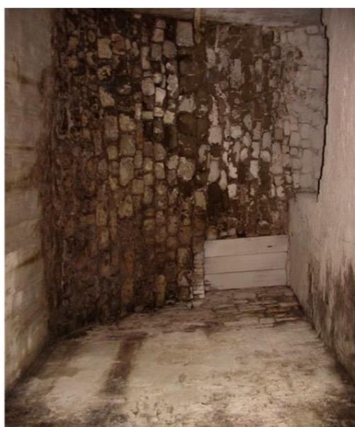
Figura 5.5 – Particolare della volta in pietra vista dal basso
