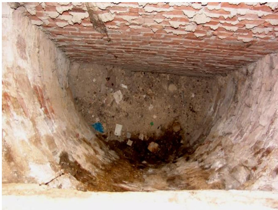
Figura 4.6 – Particolare della canna del Pozzo
