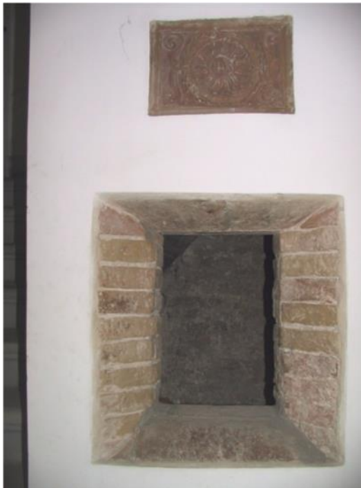
Figura 5.8 – Bocca d'attingimento sul vano scala
