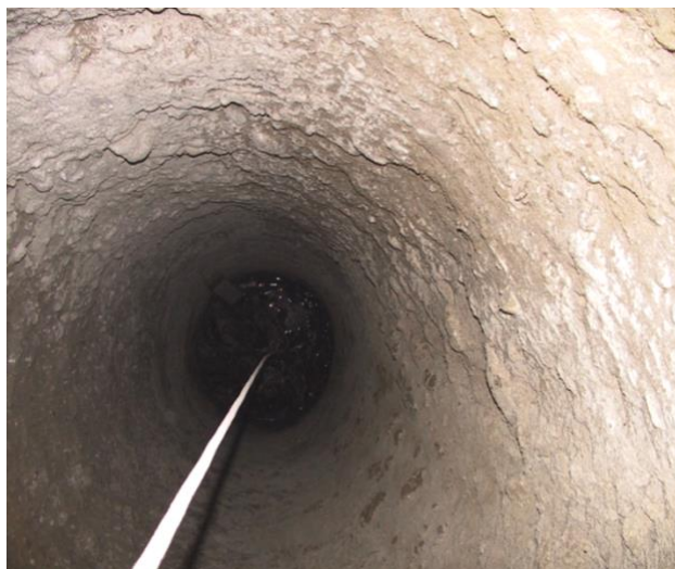
Figura 3.10 – Parte della canna del pozzo non rivestita vista dall'alto
