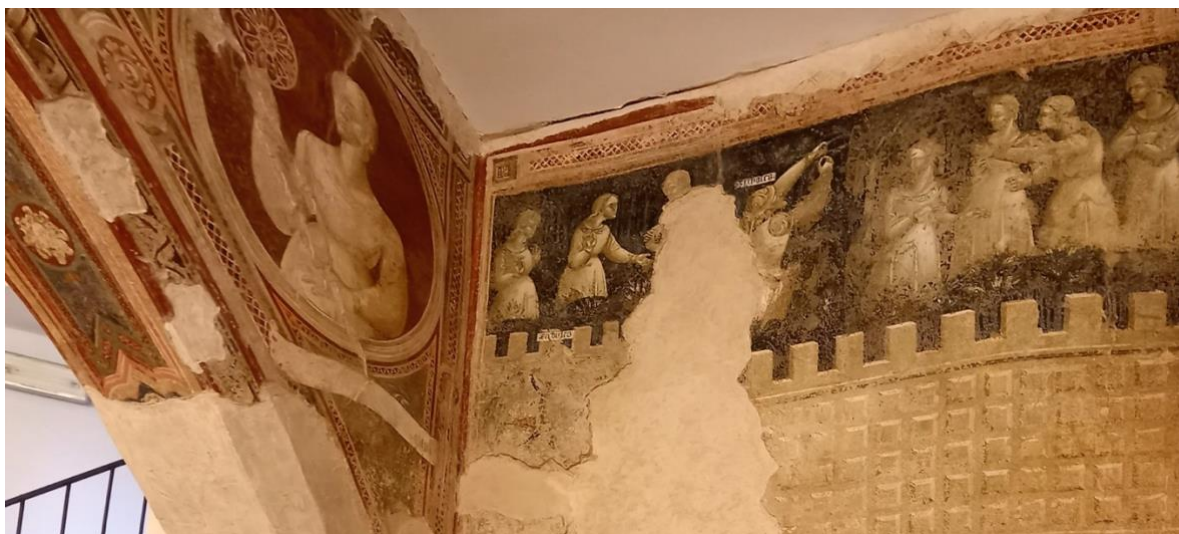
Figura 3.6 – particolare degli affreschi dopo il restauro
