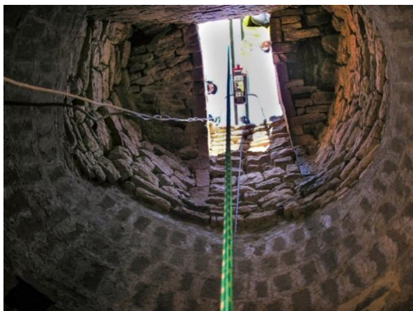
Figura 1.6 - Bocca del pozzo vista dall'interno
