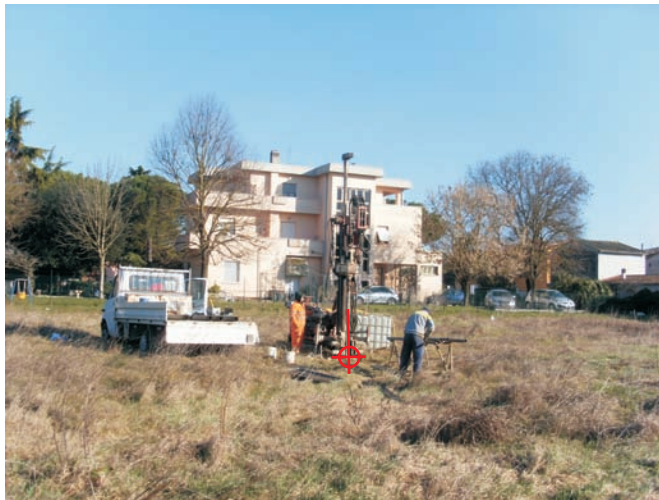
Piazzola di perforazione sondaggio n° 2 (S2)
